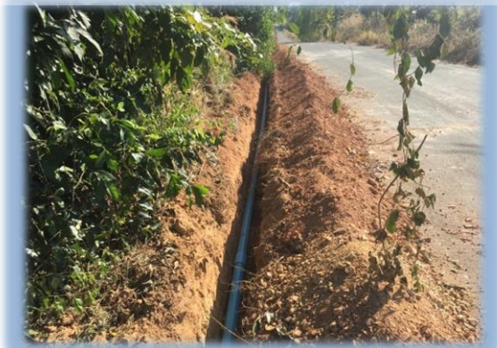
โครงการขยายเขตท่อน้ำประปา ม.7 ซอยบ้านหนองโบสถ์ – บ้านยางจุ่ม
